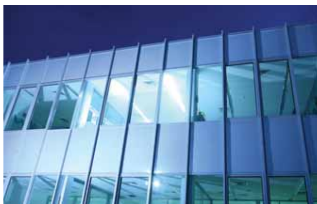
Офисно-производственно-складской комплекс, Московская область, г. Лобня
