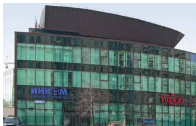
Офисный центр компании «ИНКОМ», г. Москва
