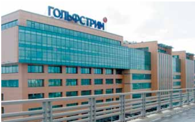
Офисный центр «Гольфстрим», г. Москва
