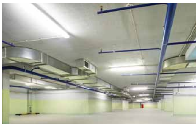
Подземная двухуровневая автостоянка, г. Королев
